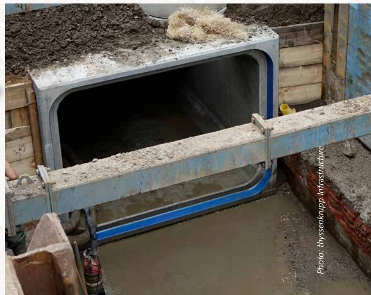
Le piquage télescopique Funke est adapté aux galeries fabriquées en place comme aux ouvrages béton grands formats.
