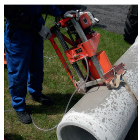
Positionnement correct de la carotteuse.
