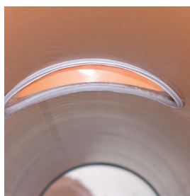
Positionnement correct de la pièce de piquage à l'intérieur d'une canalisation FABEKUN®.
