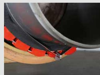
*Ajustement du fil d'eau : après le serrage préalable des vis, la clé en T permet de serrer la vis située sur le haut (flèche) afin d'obtenir un fond de même niveau. Grâce à sa conception, l'absorption des contraintes de cisaillement est également assurée. Respecter les instructions de montage jointes à l'adaptateur BSM.*
