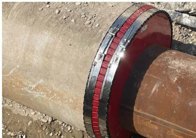
*Réduction d'un tuyau en béton DN 1000 sur un tuyau en acier DN 800*
