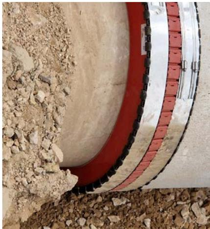
*Surdimensionnement d'un tuyau en béton existant DN 700 en tuyau en béton DN 800.*
