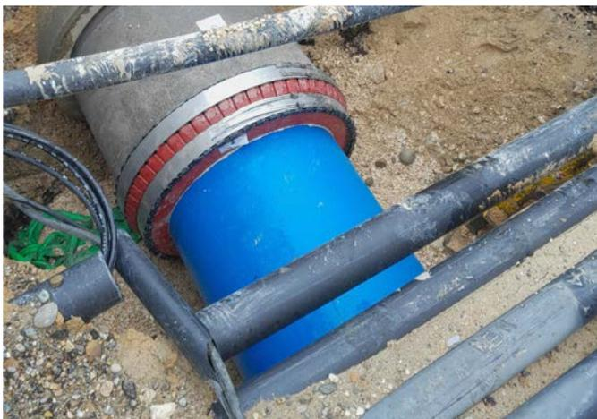
*Raccordement d'un tuyau en béton sur un tuyau HSK® de différents diamètres nominaux*
