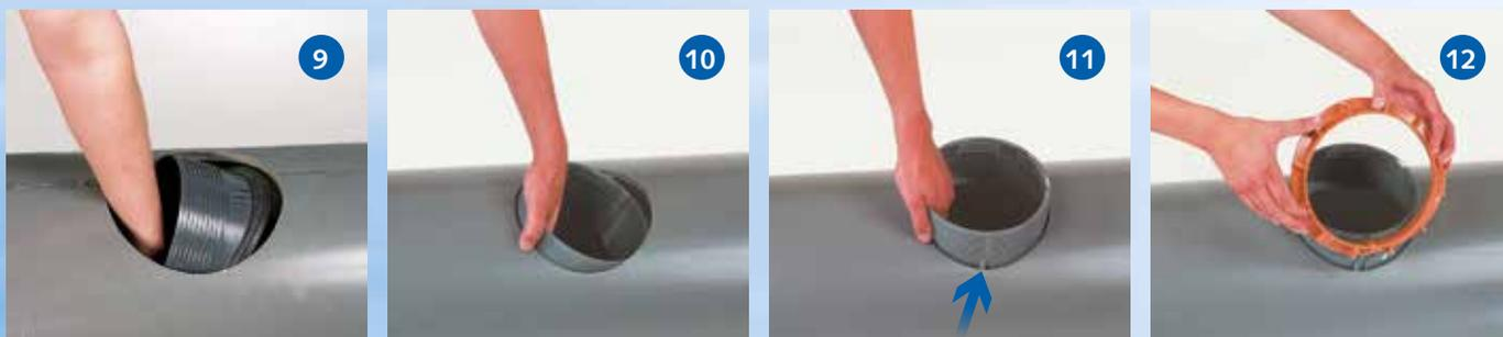
Tourner la partie inférieure du raccord CONNEX et la ramener vers le haut contre la paroi intérieure du tube (10), jusqu'à que les clips (voir flèche) (11) se libèrent afin de maintenir la pièce. Placer la bague de compensation orange sur la partie inférieure du raccord en respectant la rainure de guidage (12).
