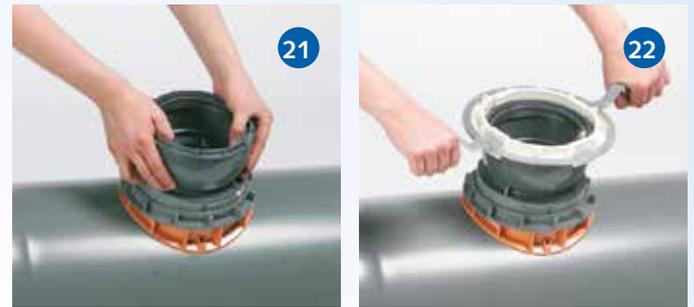
Insérer, en respectant l'axe, la partie supérieure dans la partie inférieure (20) et visser sans forcer en respectant le filetage (21). Placer l'adaptateur sur la partie supérieure. A l'aide de la clé de serrage, serrer à fond la partie supérieure jusqu'en butée (22). Pour finir, exercer de légers à-coups sur les poignées. S'assurer une dernière fois du parfait positionnement de la pièce dans le tube.
