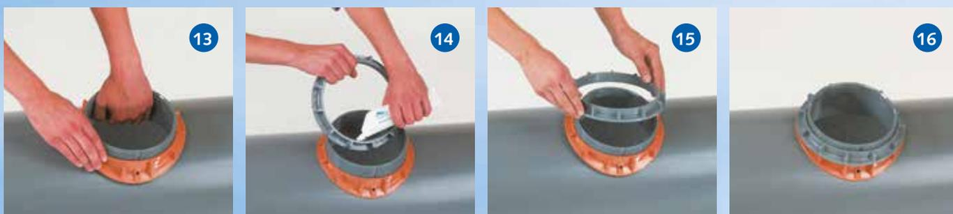
**Important: positionner la partie inférieure dans le trou de manière à ce qu'elle soit bien centrée par rapport au carottage (13)** Enduire le filetage de la bague de serrage du lubrifiant livré avec (14). Positionner la bague de serrage de manière à ce que le vissage soit facile et sans accroche (15). Remonter la partie inférieure avec une main afin de la plaquer contre la paroi intérieur du collecteur et visser la bague avec l'autre main (16).
