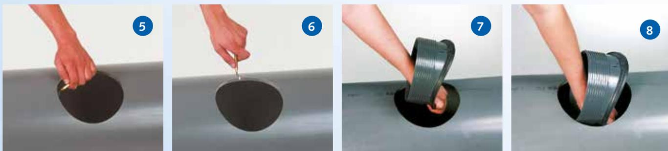
Une fois le perçage correctement effectué, ébarber la paroi intérieure (5) et extérieure (6). Insérer la partie inférieure du raccord CONNEX à l'intérieur du trou en poussant (7-9). **Ne pas mettre de lubrifiant sur le joint inférieur!**
